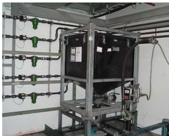
Tintas de gama. Tanques de tinta para periódico. Tintas cmy (derecha), tinta negra (izquierda)
